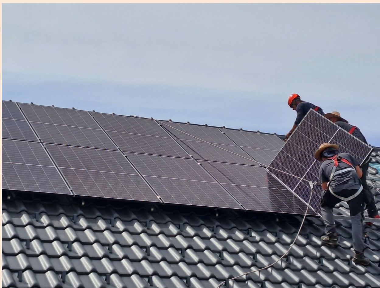
Slika 1: Strokovnjaki Bivatech d. o. o. – Elektro Požun pri montaži 28 fotovoltaičnih modulov moči 435 W p , ki sestavljajo samooskrbno sončno elektrarno 12,18 kW p
