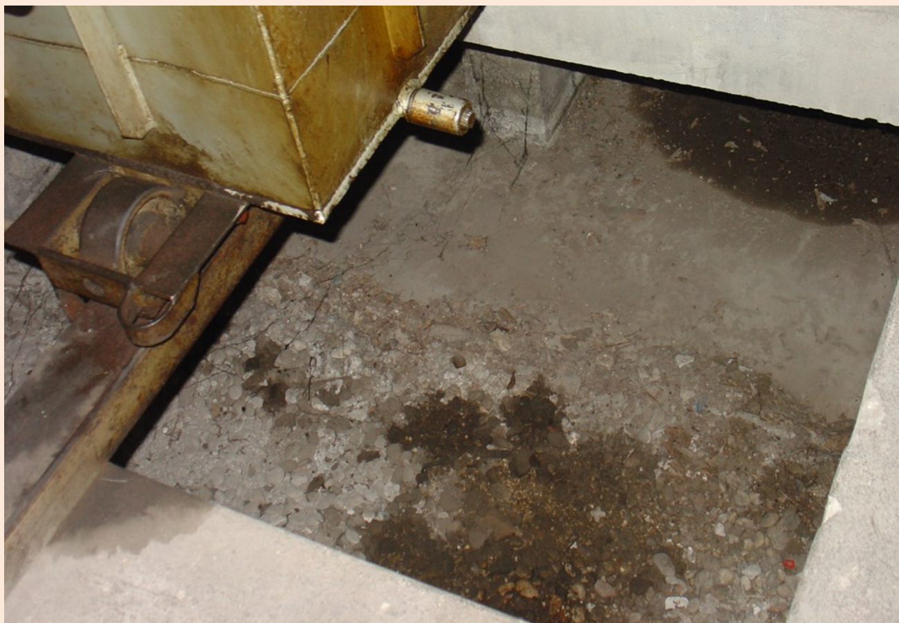
Slika 8: Prikaz oljne jame z rečnim prodom
